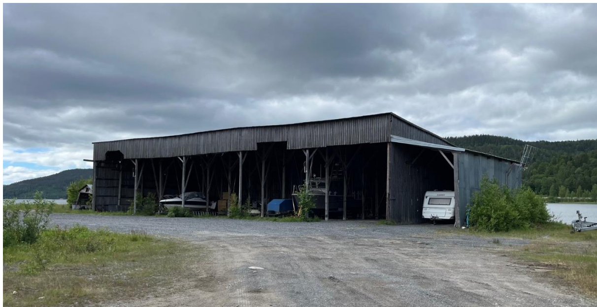
Bild 2. Äldre byggnad inom planområdet.
