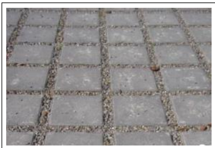
Figur 5–4. Exempel på genomsläpplig betongbeläggning med grusfogar.
