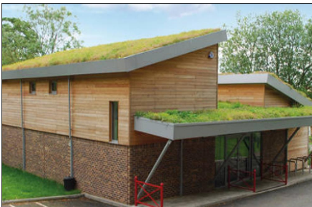
Figur 5–17. Gröna tak kan anläggas både på platta och lutande tak (Svenska Naturtak AB, 2018).
