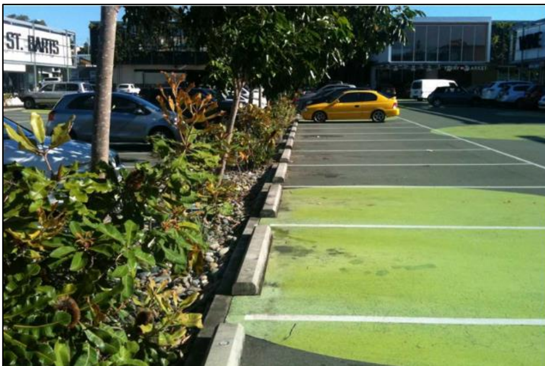
Figur 5–14. Öppning i kantsten, inlopp växtbäddar (Waterbydesign, 2014)
