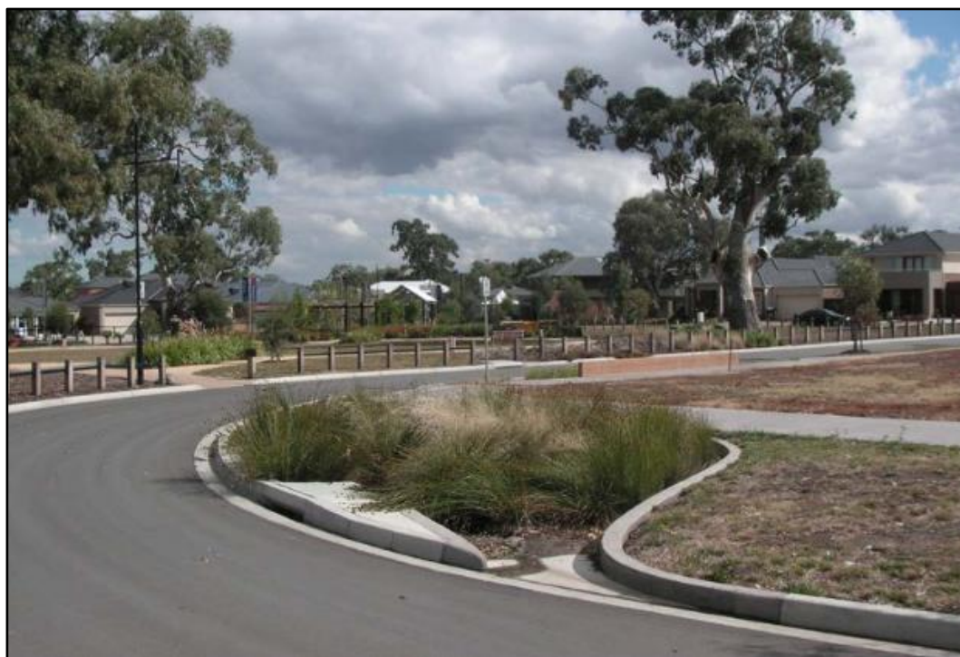
Figur 5-13. Öppning i kantsten, inlopp till växtbädd (Waterbydesign, 2014)
