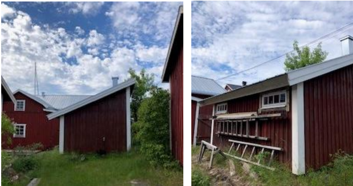
Komplementbyggnad 124 med tidstypiskt rödmålad stående träpanel med vita knutar och pulpettak.
