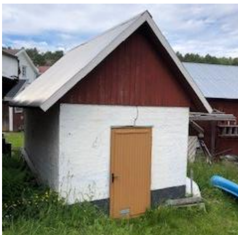
Komplementbyggnad 198 med vit putsat tegel och rödmålad stående träfasad och sadeltak.
