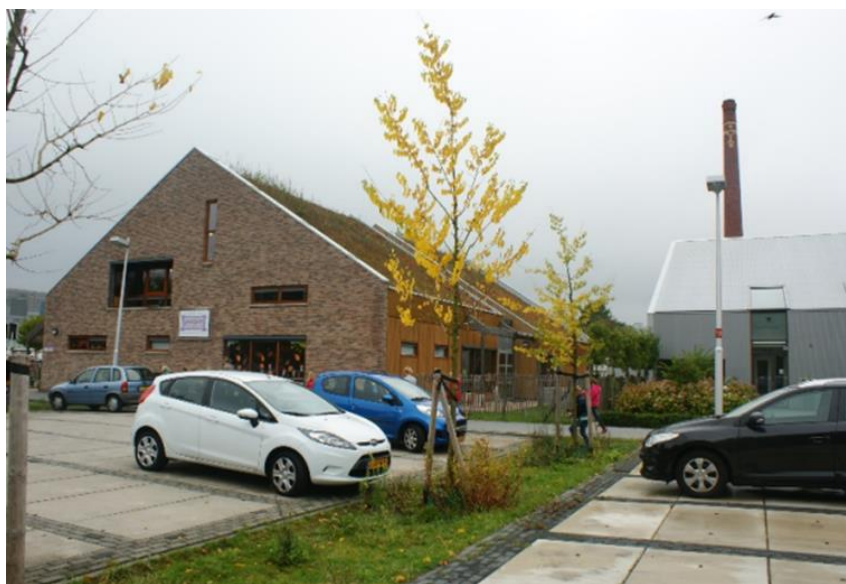
Bild 1: Ett exempel på genomsläpplig beläggning med LOD-anläggning (LOD-anläggning är växtbädd, regnbädd, skelettjord eller annan grön dagvattenanläggning). Källa: Nacka kommun
