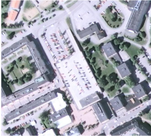
Foto från 2010 över takparkering.
