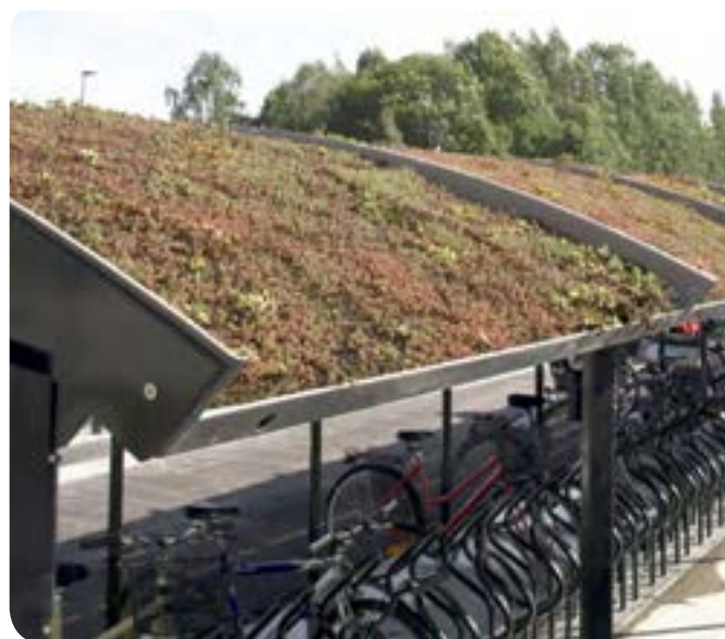
Cykelställ med ramlås och sedumtak.
